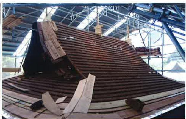
安芸郡府中町鎮座の多家神社（飯田誠宮司）では広島県指定重要文化財である宝蔵の保存修理工事が行われた。今回は平成二十八年七月～十一月の期間で屋根を中心の保存修理となつた。前回（平成五年）から二十三年を経て、傷みの激しい檜皮の葺き替えと棟瓦の補修が行われた。檜皮は職人により規則正しく並べられ、竹釘で固定、瓦は一枚一枚を点検、可能なものは接着剤で修理し、修理が不可能なものは同じ形のものを焼成して復元された。
